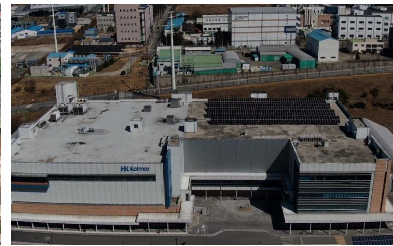
세종공장 태양광 발전설비 2022년 04월~
